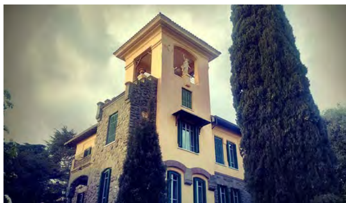
Fig. 6 - Il "Villino Volterra" ad Ariccia (Foto dell'Autore).
