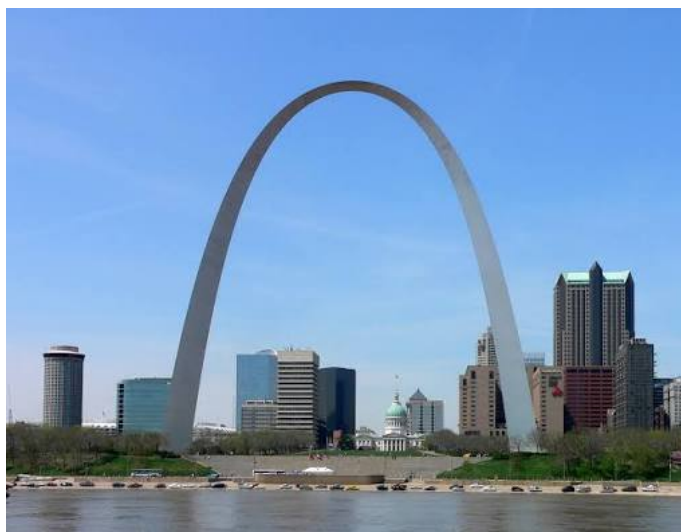
Fig. 11 - Arco di catenoide rovesciata.
